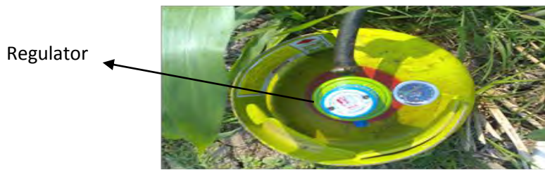
Gambar 2.17 Pemasangan regulator tekanan tinggi pada tabung gas LPG
