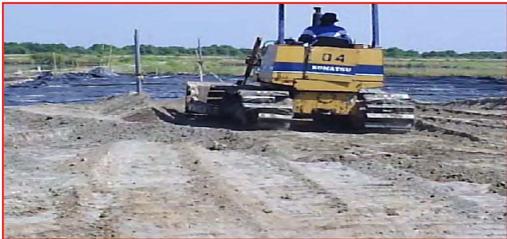
Gambar: Penghampanan material pada permukaan trase jalan yang diberi geotextile sparator
