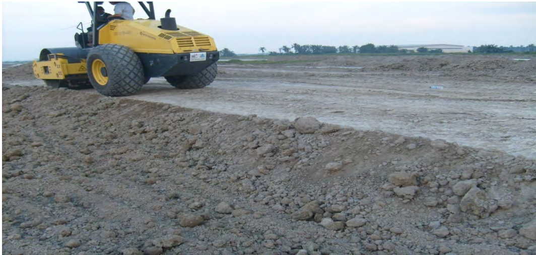
Gambar: Hasil Pemadatan pada permukaan trase jalan diberi yang geotextile sparator
