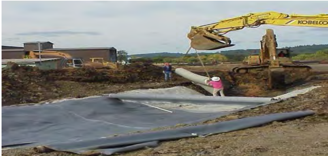
Gambar: Pemasangan permukaan trase jalan dengan lapisan geotextile sparator
