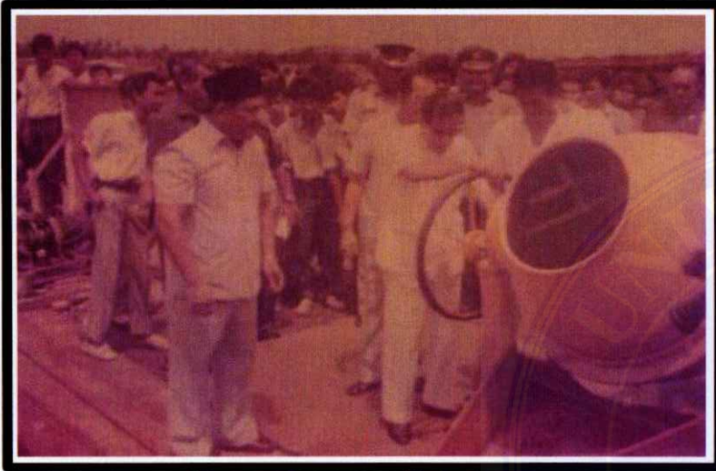
Prestasi Universitas Medan Area Peletakan Batu Pertama Gedung UMA
