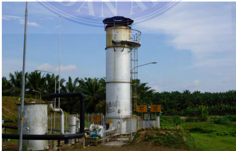
Gambar 2.7 Flare Biogas . Sumber : Winrock Internasional 2015.
