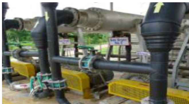
Gambar 2.4 Dehumidifier Biogas. Sumber : Winrock Internasional 2015.
