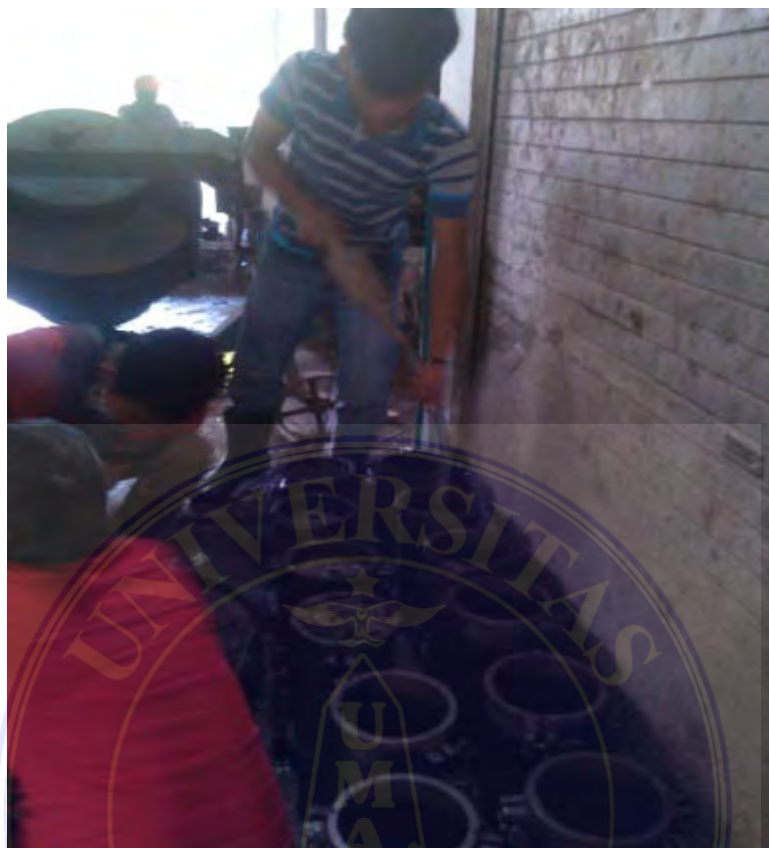
Gambar 9. Pemasangan Dengan Vibrator
