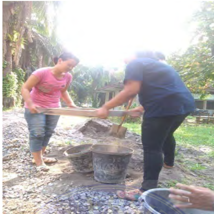
Gambar 1. Persiapan dan Pengayakan Material
