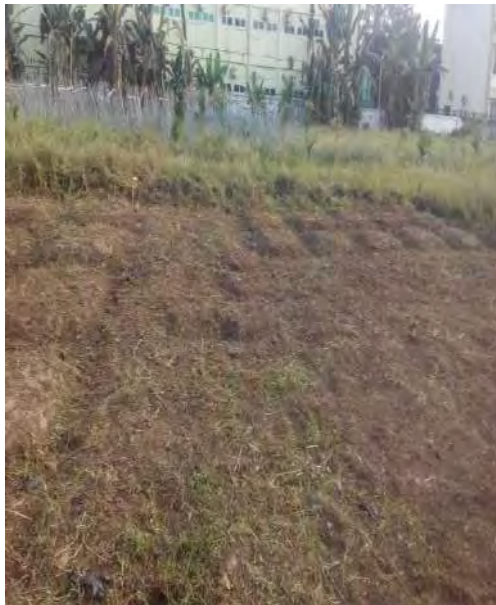
E. Lahan yang sudah di bersihkan.
