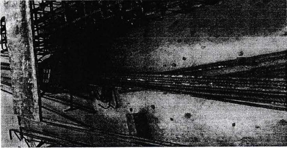
Gambar 3.20 Pekerjaan pemotongan dan pembengkokan tulangan
