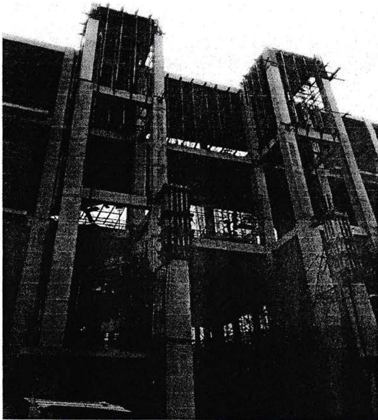
Gambar 3.8 Bekisting/ Cetakan
