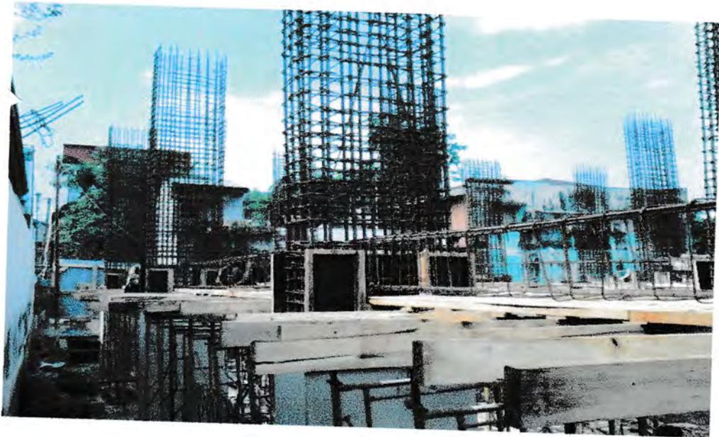
Gambar Pekerjaan Penulangan Balok
