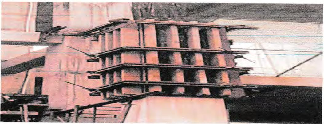
Gambar 2.4 : Bekisting/Cetakan
