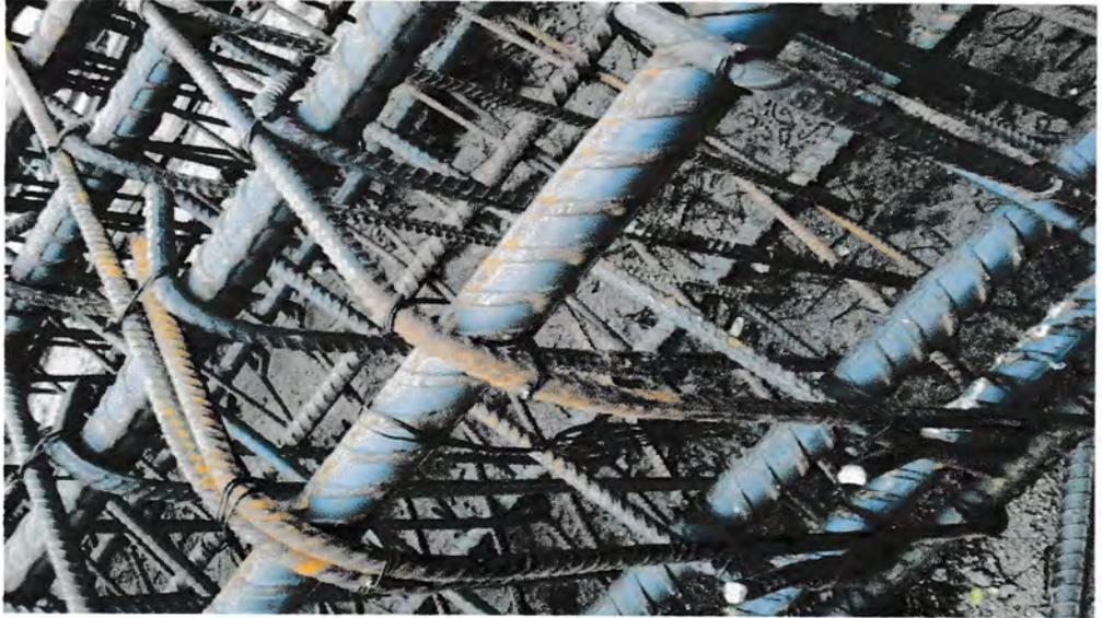
Gambar : Pembesian Kolom Dengan Besi Beton Ulir
