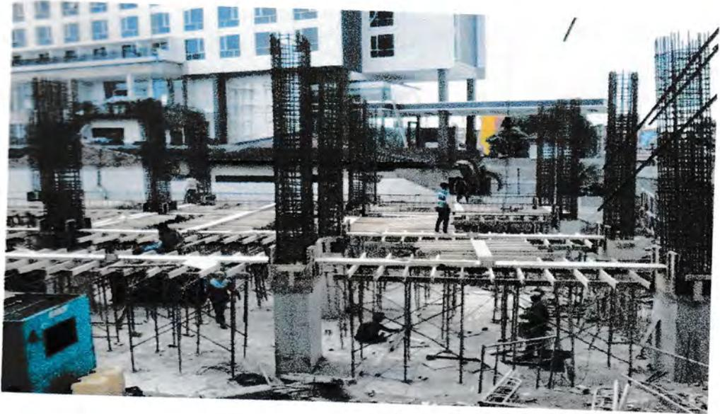
Gambar : Pekerjaan Bekisting Balok
