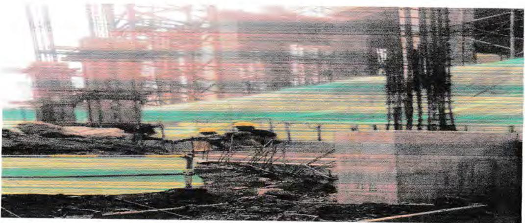
Gambar 2.9 : Bekisting Kolom
