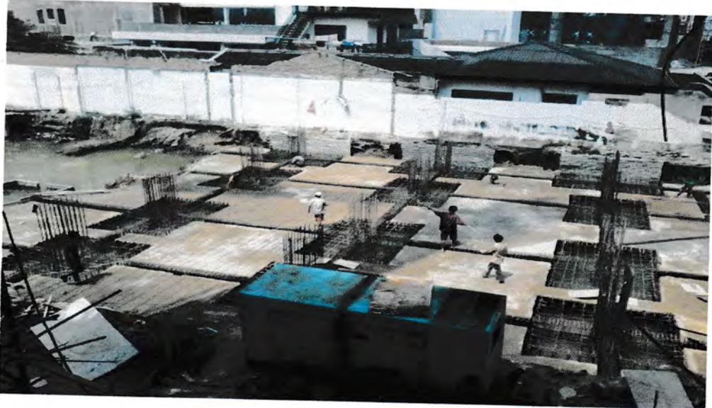
Gambar : Pondasi dan tiang kolom untuk pengikat balok sloof
