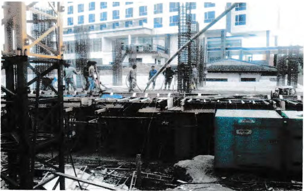
Gambar : Pekerjaan Pengecoran Pelat Lantai
