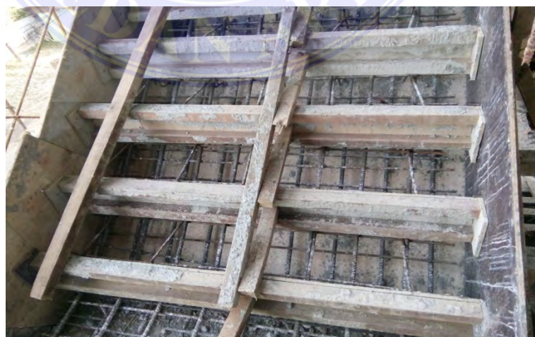
Gambar 3.12 Pemasangan Bekisting Tangga
