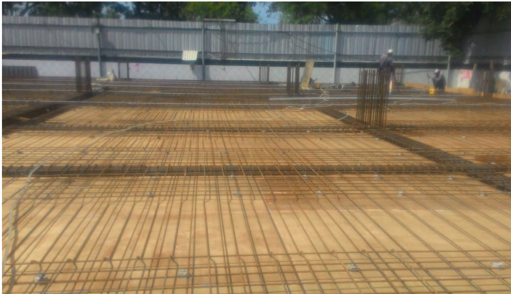
Gambar. Tulangan Plat Lantai yang sudah di pasang
