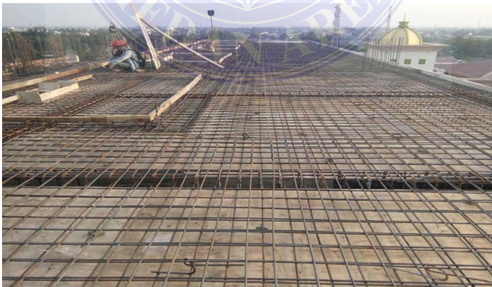
Gambar 3.7. Tulangan plat lantai
