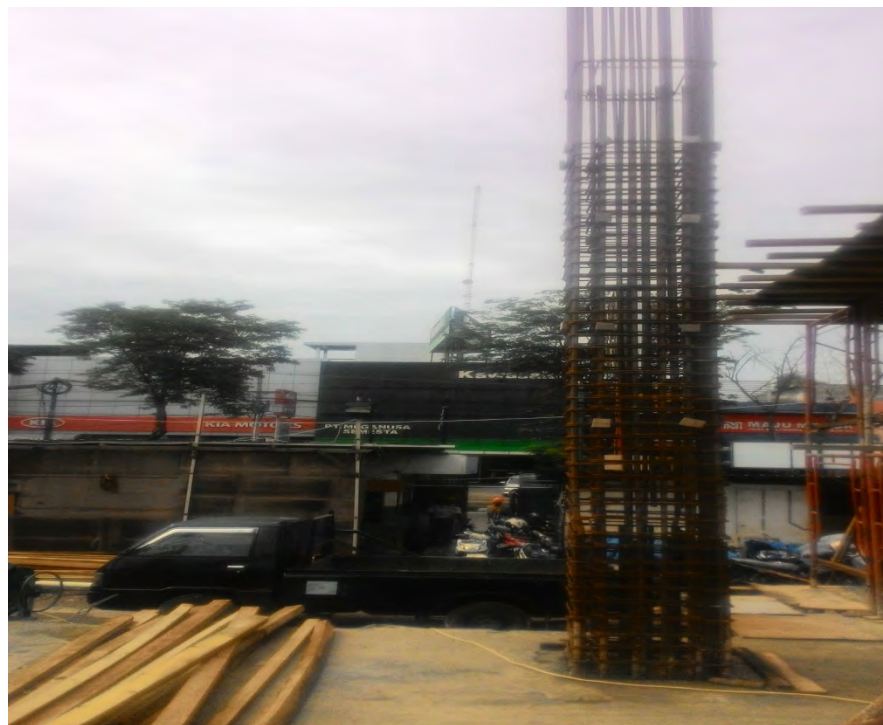
Gambar. Tulangan Kolom Yang Sudah Berdiri Lokasi : Jalan Gatot Subroto , Medan
