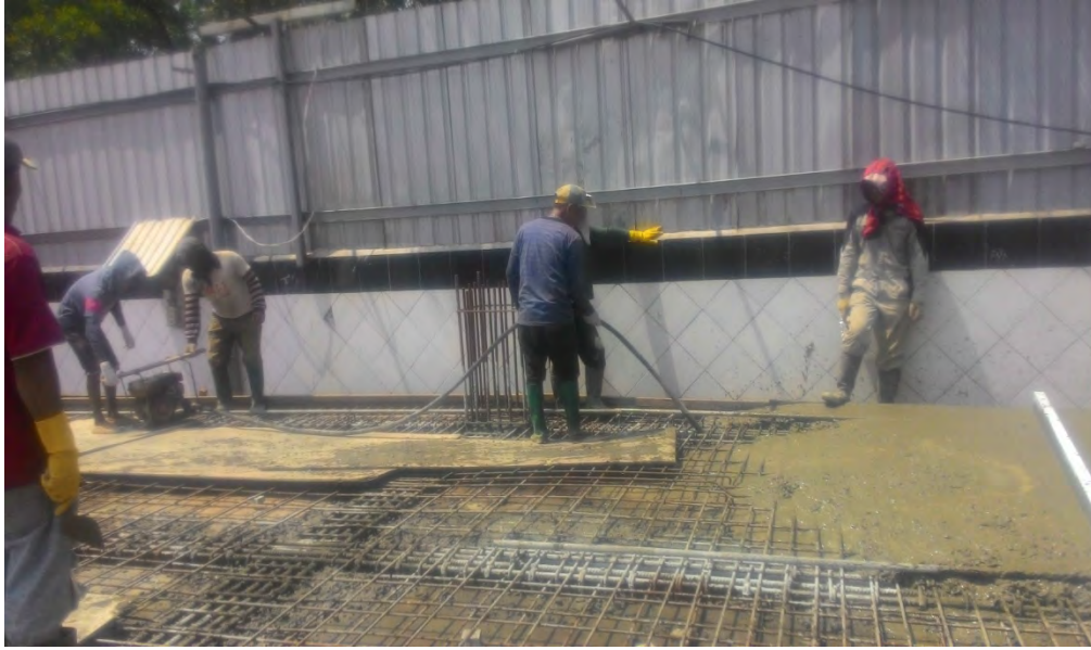
Gambar. Pengecoran Plat Lantai Lokasi : Jalan Gatot Subroto , Medan
