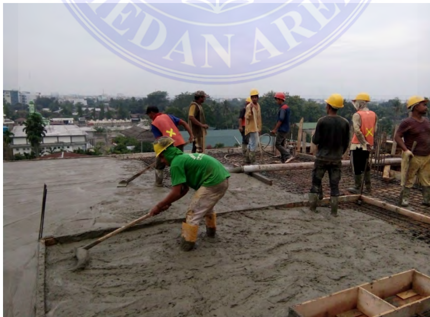
Gambar 3.15 Pengecoran Plat Lantai
