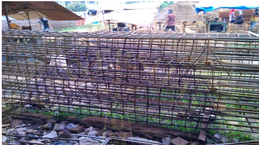
Gambar 3.4. Pekerjaan pemotongan dan pembengkokan tulangan
