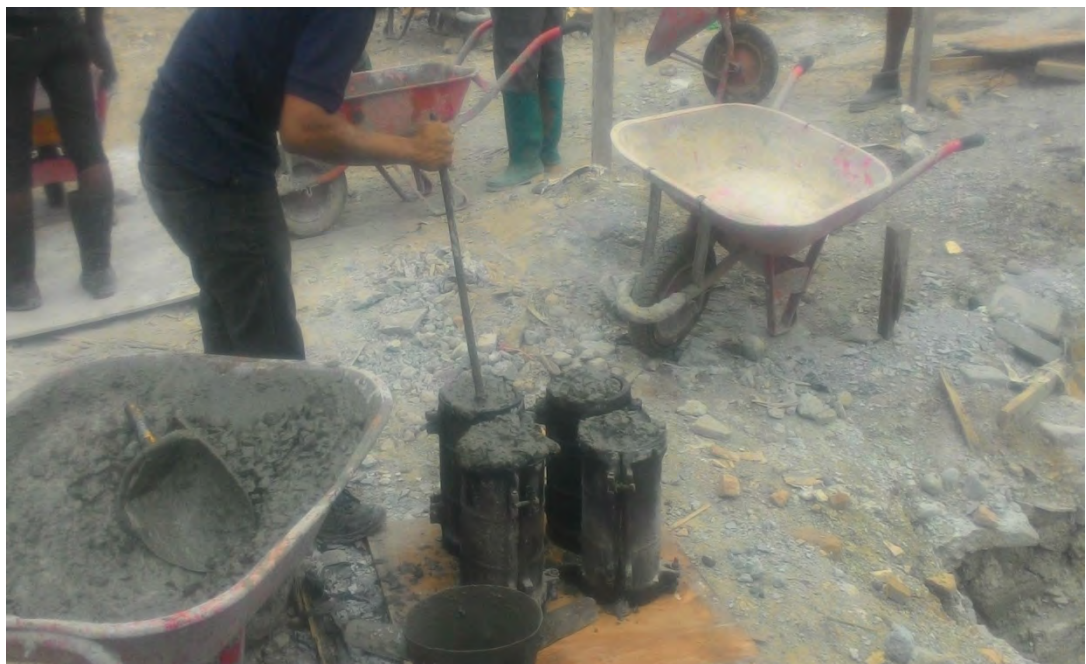
Gambar. Pengujian Beton Lokasi : Jalan Gatot Subroto , Medan
