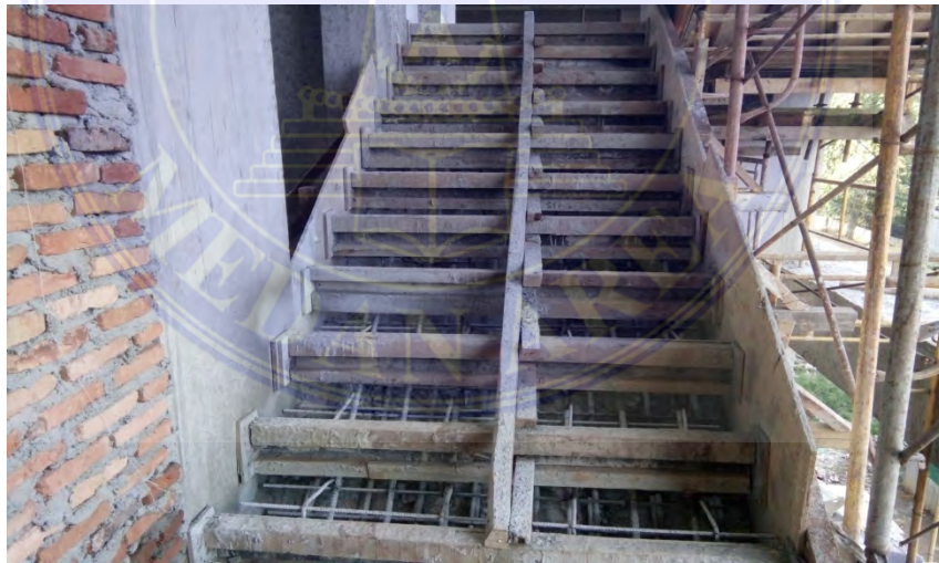
Gambar 3.13 Pembesian Plat tangga
