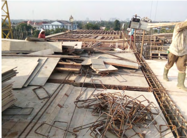
Gambar 3.12 Pemasangan Bekisting Balok dan Plat Lantai
