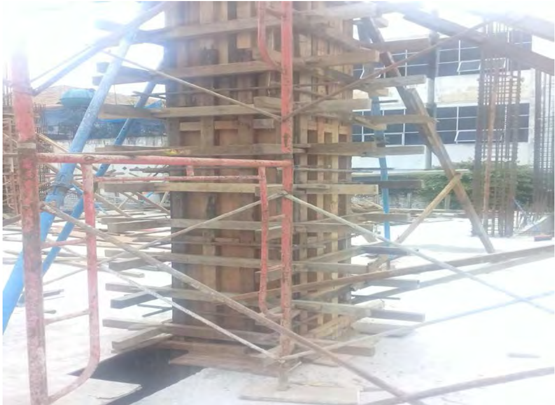
Gambar. Pemasangan Bakisting Kolom Lokasi : Jalan Gatot Subroto , Medan
