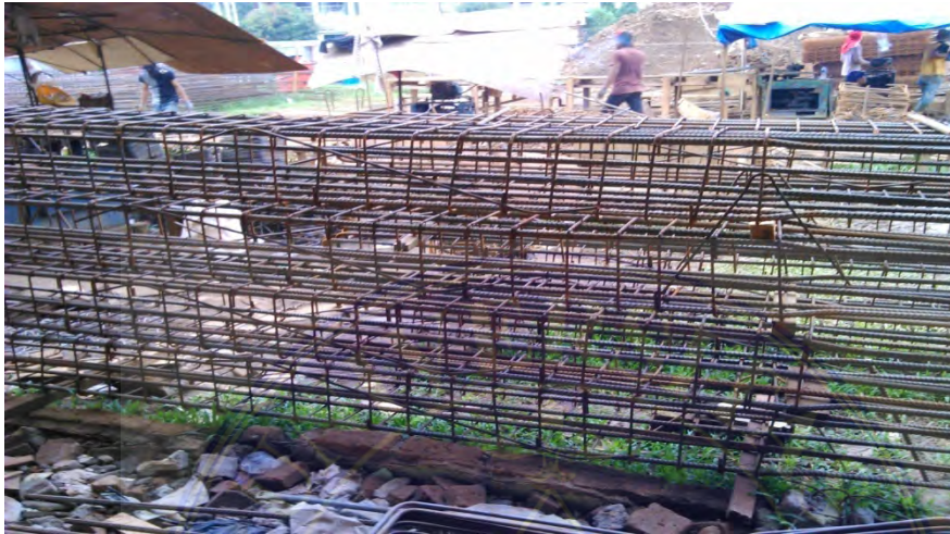
Gambar 3.4. Pekerjaan pemotongan dan pembengkokan tulangan
