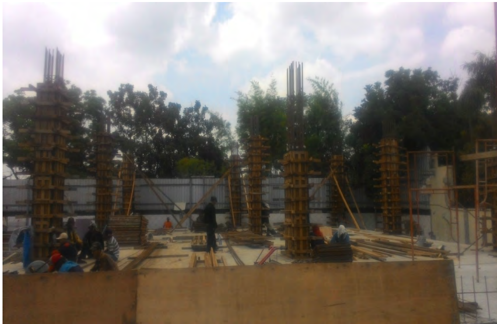
Gambar. Proses Pengeringan Kolom Lokasi : Jalan Gatot Subroto, Medan
