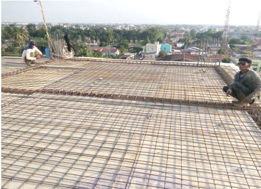
Gambar 3.13 Pembesian Plat Lantai
