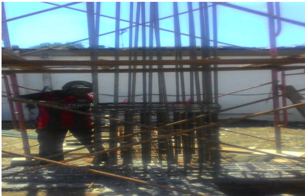
Gambar. Making Kolom dengan D22
