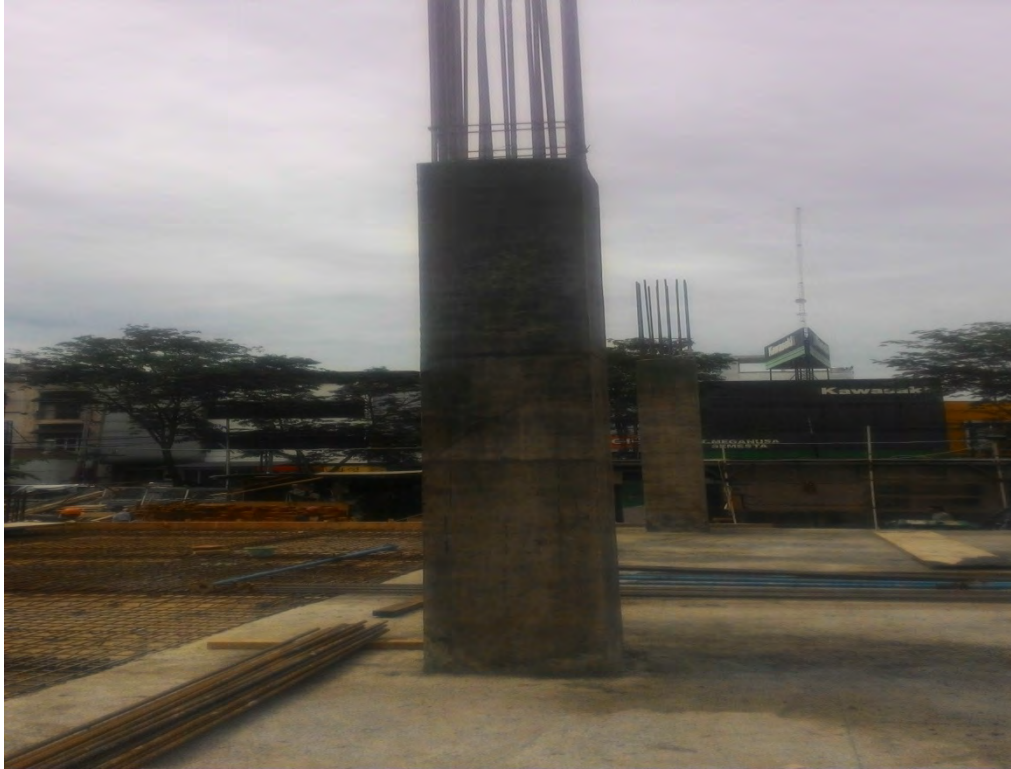
Gambar. Kolom Selesai
