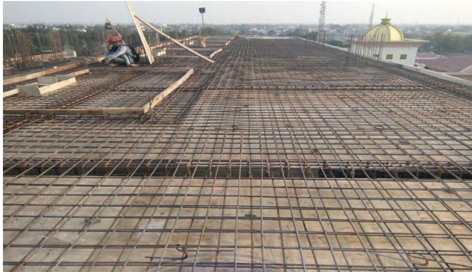
Gambar 3.7. Tulangan plat lantai
