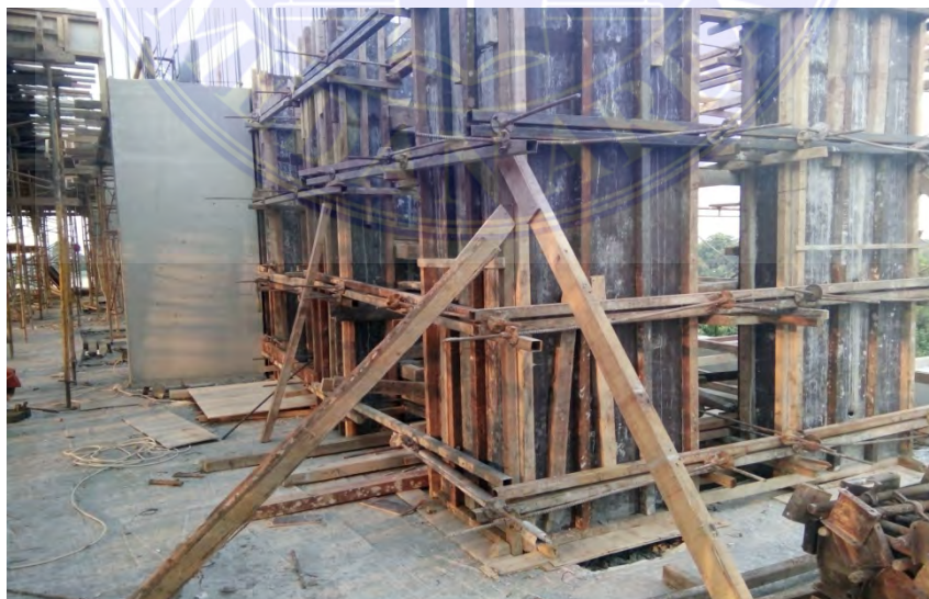
Gambar 3.1. Bekisting kolom
