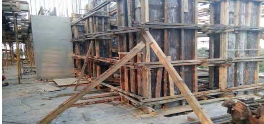
Gambar 3.1. Bekisting kolom
