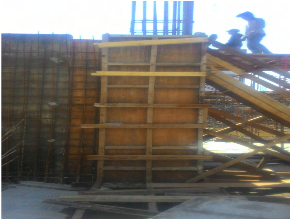
Gambar . Proses Pengecoran Kolom Lokasi : Jalan Gatot Subroto, Medan
