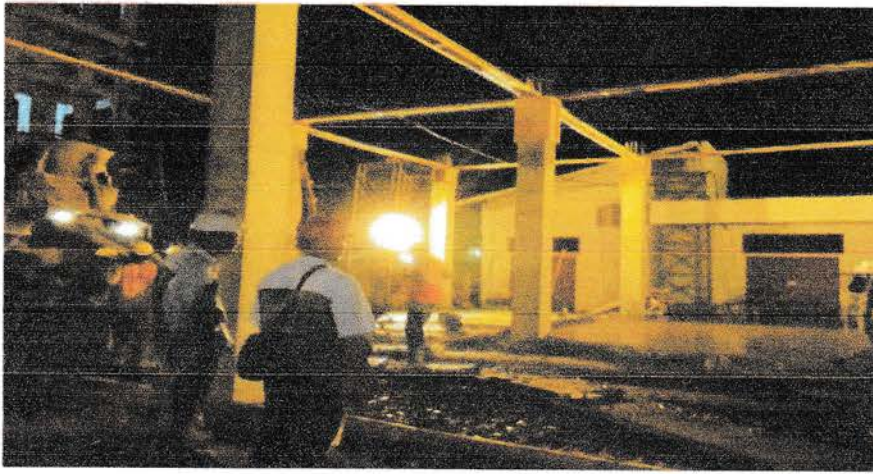
Gambar : Pekerjaan Pemasangan Bekisting, Pembesian Kolom & Pengecoran
