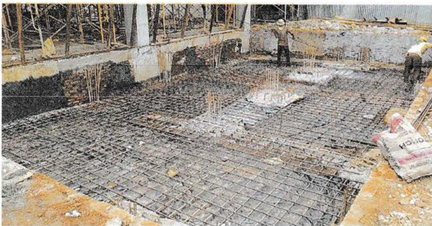
Gambar : Pekerjaan Plat Lantai
