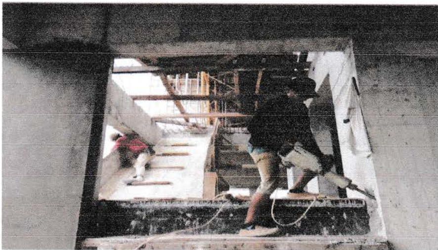
Gambar : Pekerjaan Pemasangan Bekisting & Pembesian Tangga
