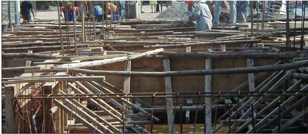
Gambar 2.2 Bekisting konvensional/ tradisional dengan kayu dan bambu (Sumber: Google)
