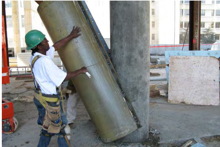
Gambar 2.9 Bekisting Kolom MFG fiberglass (Sumber: www.formtechinc.com )
