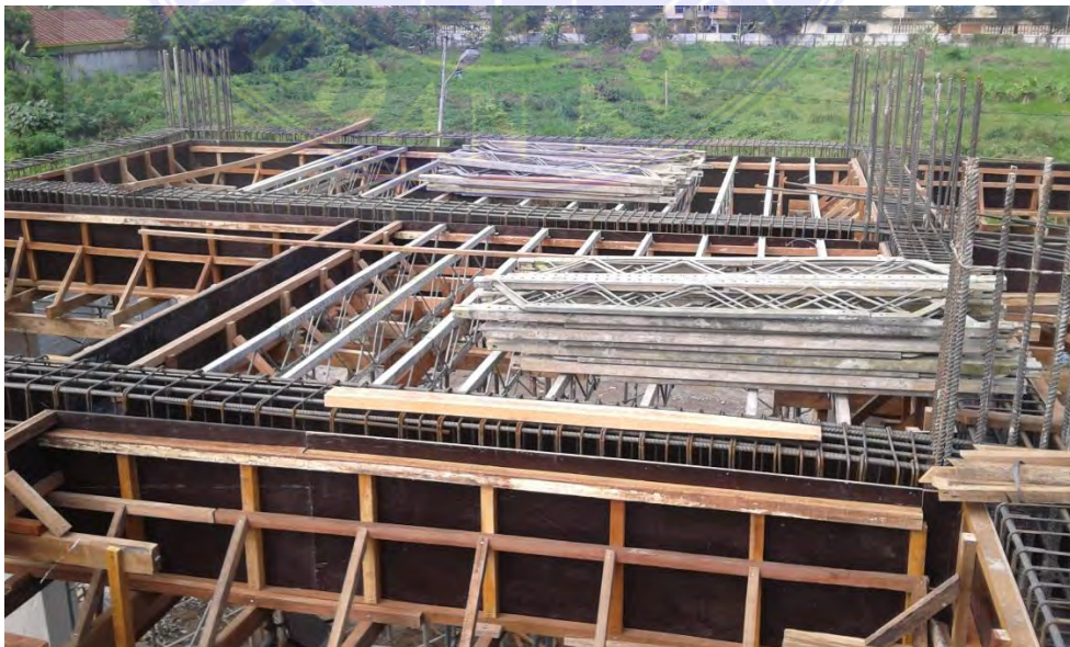
Gambar 2.3 Bekisting semi modern dengan kayu dan horry beam (Sumber: Dokumentasi proyek Sekolah Yayasan Cinta Budaya)
