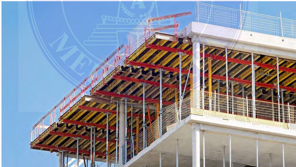
Gambar 2.4 Bekisting modern dengan slab table Variodeck (Sumber: Brosur PERI)
