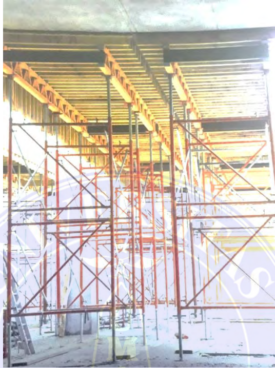
Gambar 2.20 PD-8 shoring (Sumber: Dokumentasi PT. Beton Perkasa Wijaksana)
