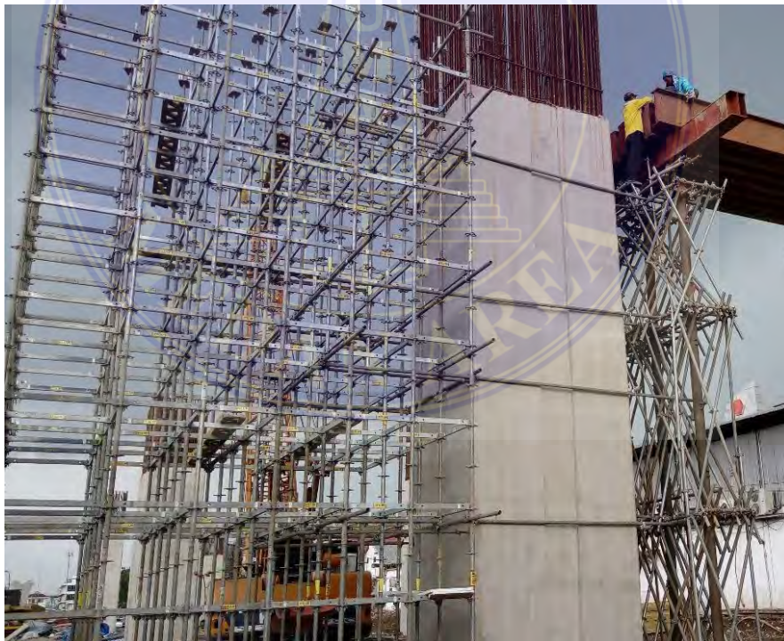
Gambar 2.17 Peri Up shoring (Sumber: Dokumentasi proyek Jalan Layang Kereta Api Medan)
