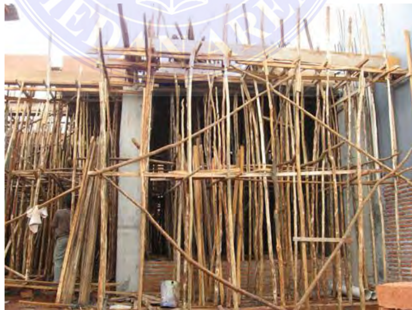
Gambar 2.10 Perancah kayu atau bambu (Sumber: google)
