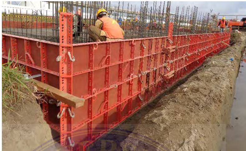
Gambar 2.8 Bekisting Peri handset berbahan baja (Sumber: Dokumentasi PT. Beton Perkasa Wijaksana)
