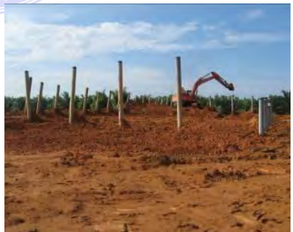
DOKUMENTASI PROSES SAAT DILAKUKAN PEMANCANGAN
