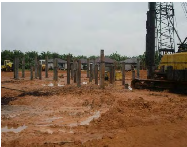
DOKUMENTASI PROSES SAAT DILAKUKAN PEMANCANGAN
