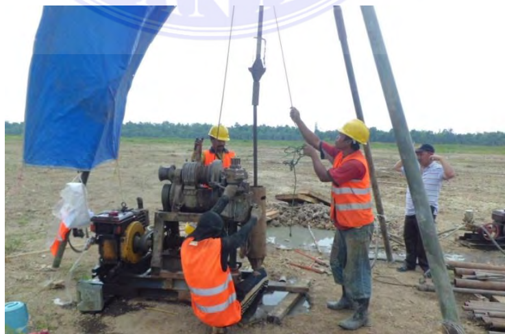
Gambar 2.33 Sumber Air Dari Sumur Bor Untuk Pengadukan Beton
